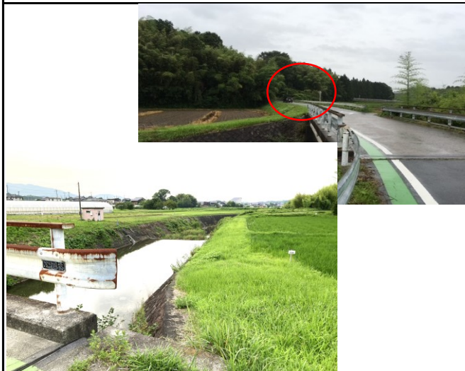
危険箇所の現状
