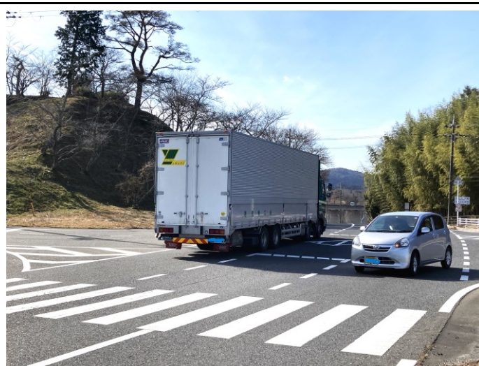
危険箇所の現状
