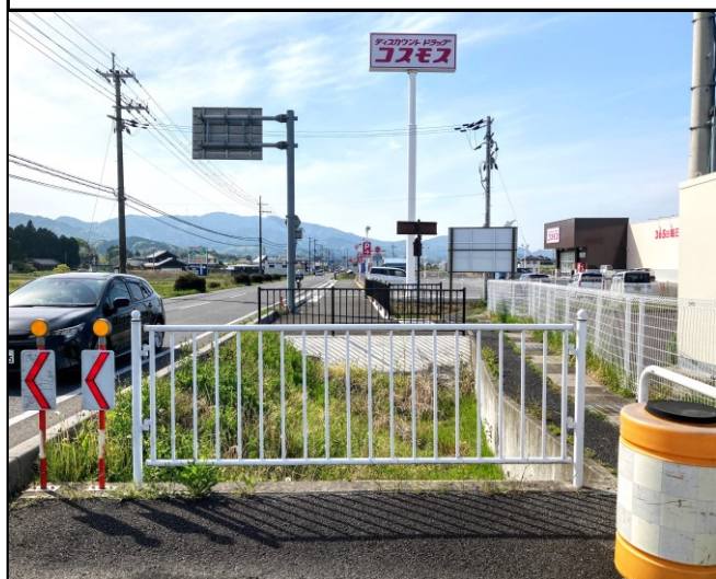
危険箇所の現状
